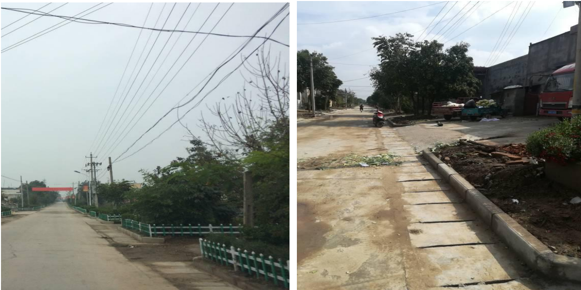
图 11.3 污水排入有盖板暗渠现状图
