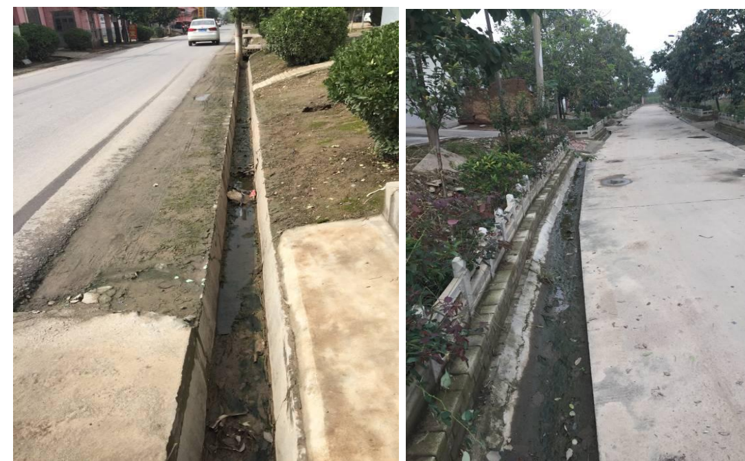
图 11.2 污水排入无盖板渠现状图
