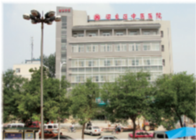
2010年，阎良区中医医院门诊楼建成
