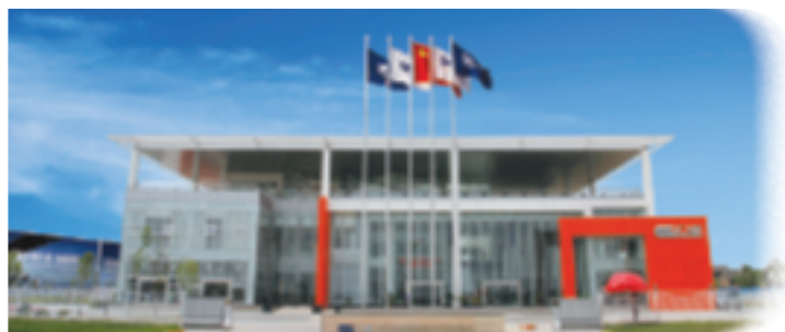
2006年，国家航空产业基地管委会办公楼建成
