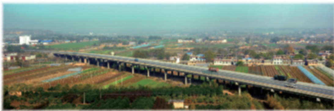
关中环线阎良段跨咸铜铁路侯西铁路航空城大桥（摄于2010年）
