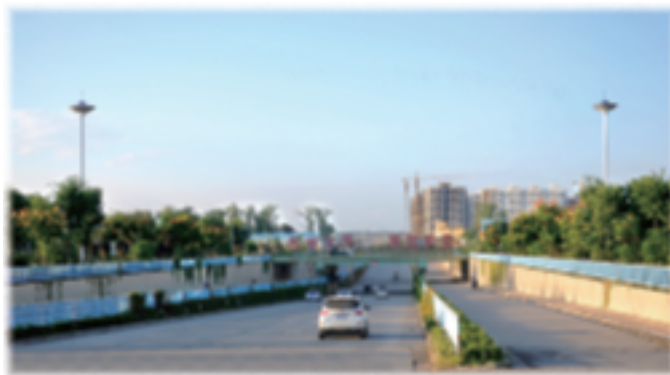
迎宾大道下穿前进路咸铜铁路立交桥（摄于2010年）
