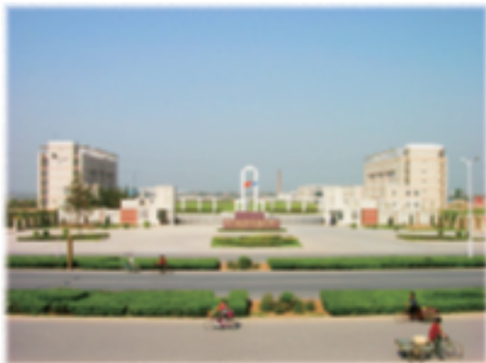
2006年，建设中的西安航空职业技术学院新校区
